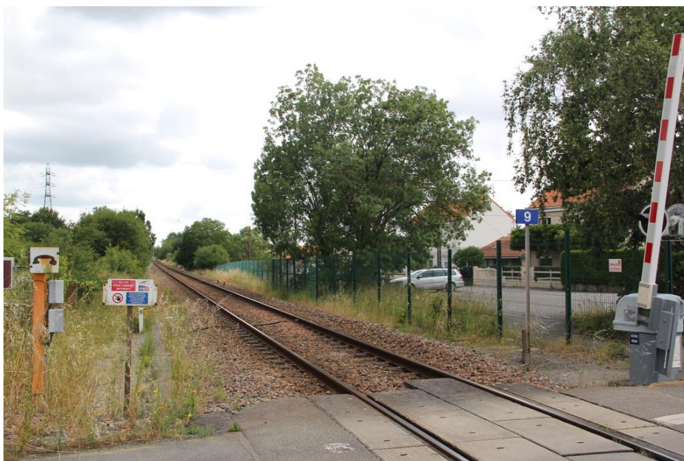
La voie ferrée à proximité immédiate des habitations
