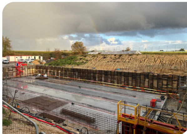
Bassin de traitement des eaux
